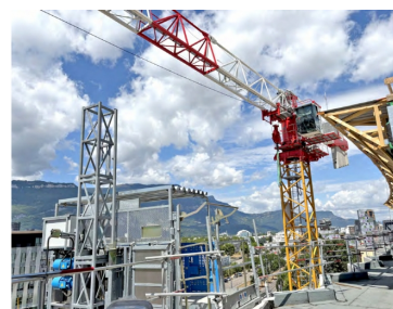
La construction du bâtiment People Connect avance bien Photo : © Caroline Thermo-Liaudy
