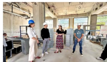
Visite de chantier officielle. Photo : © Caroline Thermo-Liaudy -
