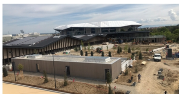
Le bâtiment de la piscine, la piscine et le court central vus du toit de l'académie, le club, et le Groupama stadium au fond.
