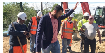
Visite de chantier.
