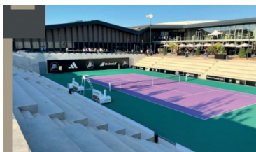
Un court extérieur de 1 000 places pouvant servir à divers événements de spectacles. Photo : ©E.S.
