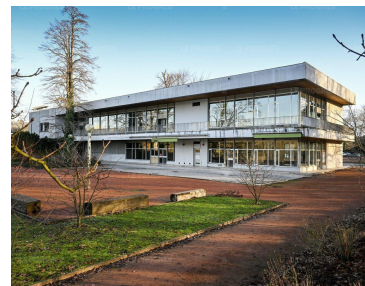
Vacant depuis 2013, le bâtiment sera bientôt entièrement réhabilité pour devenir un lieu axé sur la transition écologique. Photo Joel Philippon
