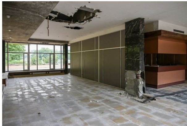
Le sol et les colonnes en marbre sont conservés. Photo Maxime Jegat
