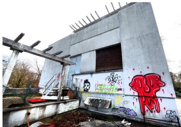
Témoin de l'architecture des années 60, le Chalet et ses façades en béton est vide depuis 2013. Photo Richard Mouillaud
