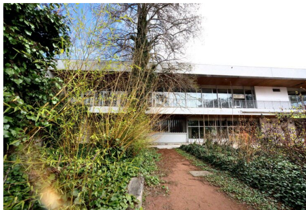
Le projet de réhabilitation voit le jour après la désignation par la Ville de Lyon d'un groupement composé du promoteur Yousse, de la Fondation GoodPlanet, de La Fabuleuse Cantine et de la Maison Gutenberg. Photo Richard Mouillaud
