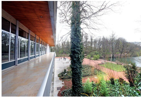
Coursives, longues ouvertures, toiture-terrasse... Le Chalet du parc est un pur produit du mouvement moderne. Photo Richard Mouillaud
