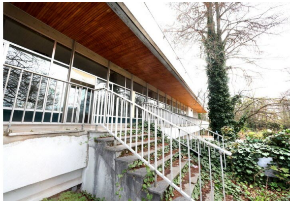
L'édifice a été construit en 1964 selon les plans des architectes Charles Damburn et Jean Duthion. Photo Richard Mouillaud
