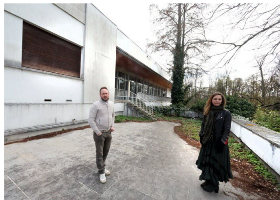
À la fin des années 90, on envisageait de le démolir, considérant l'ouvrage comme « un élément perturbateur » ou « élément à détruire », raconte Charlotte Vergély. Depuis, c'est « un virage total » qui a été amorcé, avec l'idée de « reconsidérer le déjà-là ». Photo Richard Mouillaud
