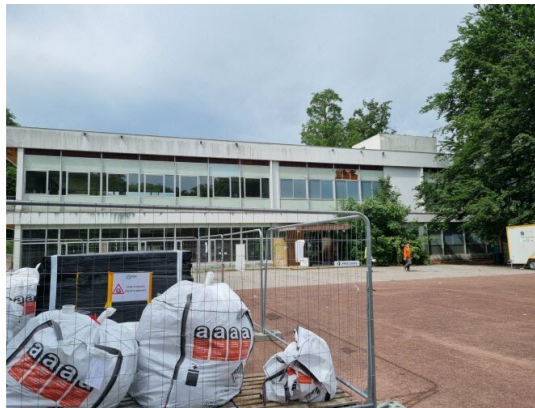
Le Chalet du parc en chantier. Photo Régis Barnes
