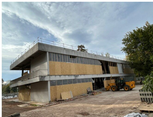
Les travaux ont commencé au chalet du parc. Il rouvrira ses portes en septembre 2026. Photo Tatiana Vazquez
